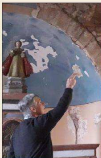
« Les travaux vont démarrer au printemps, sur l'abside et les deux transepts », précise Patrice Gobin, le maire. Photo JSL/FRÉDÉRIC RENAUD
